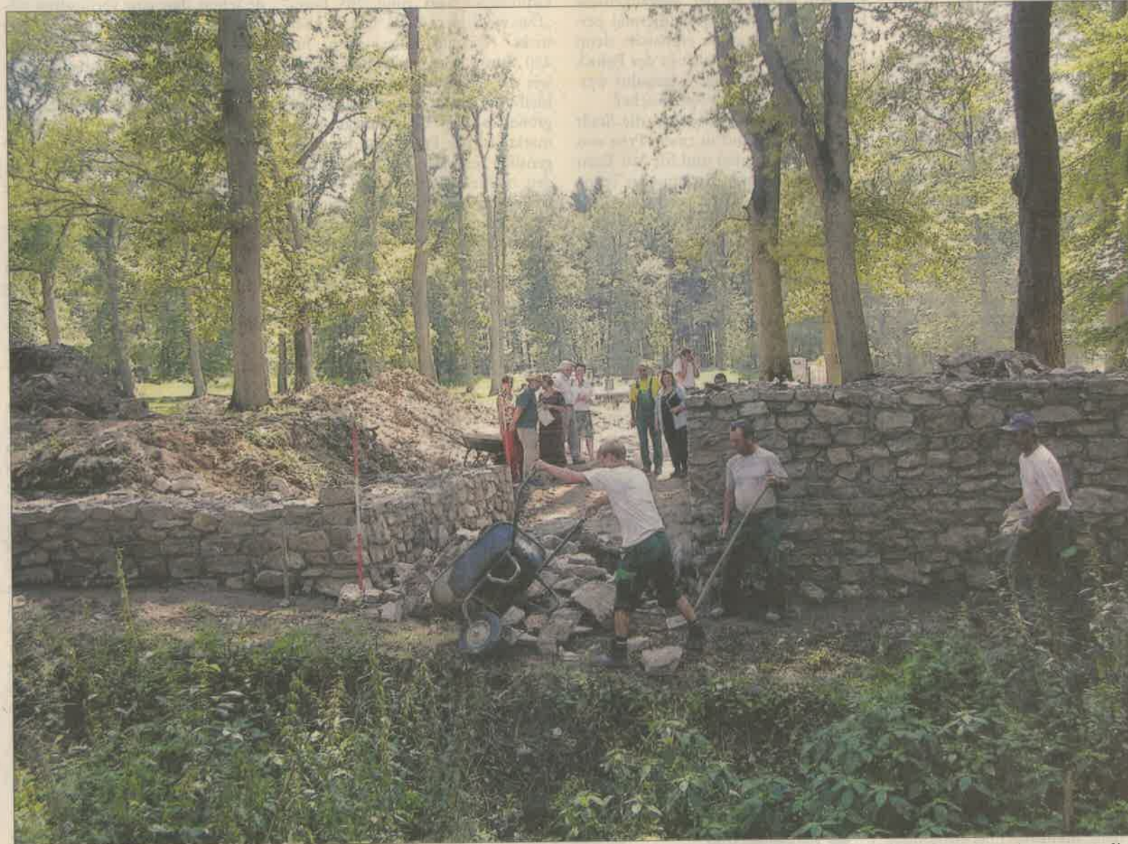
Nach Abschluss der Sanierungs- und Rekonstruktionsarbeiten an der Kapersburg wird das Römerkastell als erlebbare Parkanlage zugänglich sein. Im Vordergrund sind noch die wuchernden Grünpflanzen zu erkennen, die zuvor das ganze Areal überzogen hatten. Foto: Pieren
